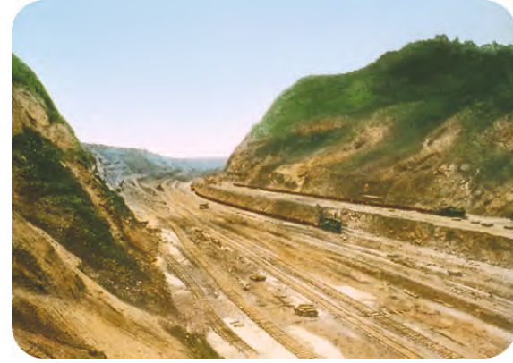
పనామా కాలువలో కులేబ్రా మార్గం [త్రవ్వబడిన మరియు అత్యంత కష్టమైన భాగాలలో ఒకటి]
